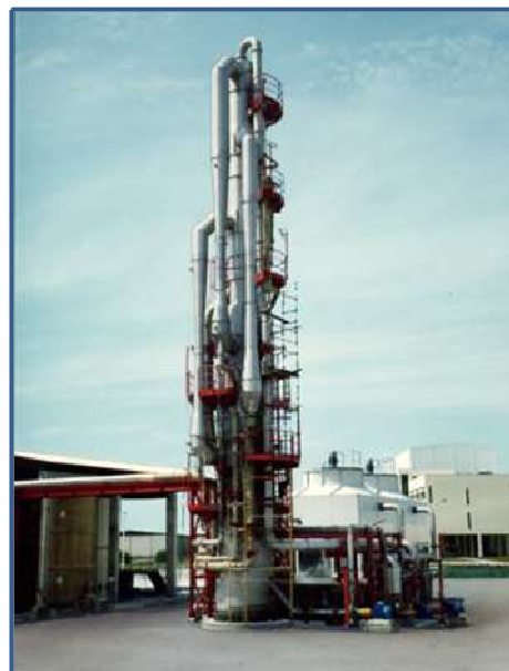
Ångstrålkylanläggning on site i Portugal
